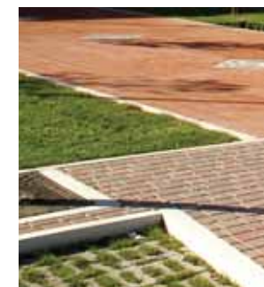
Esempio di lavorazione delle pavimentazioni esterne; Complesso FIDIA: Demetra
